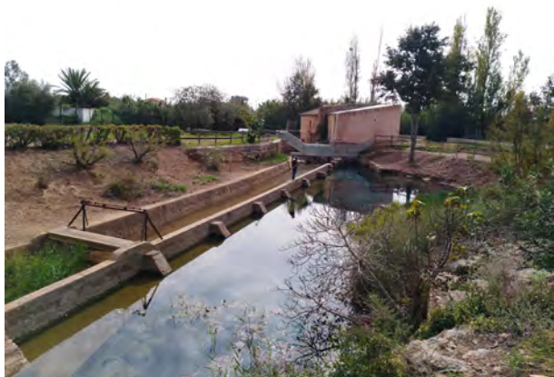
Patrimoni construït: el molí de la Font (Castelló).
