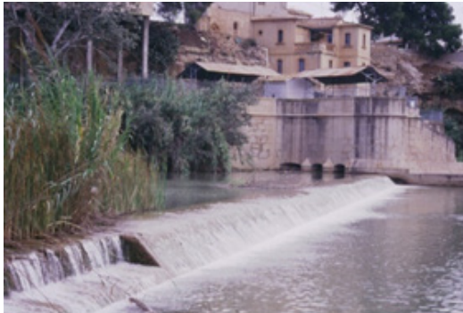
Figura 17. Nuova Diga di Castellón/Almassora.
