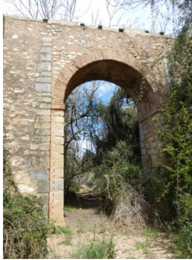
Figura 11. Acquedotto del Barranc del Malvestit. Elaborato dagli autori
