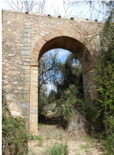
Figura 11. Acueducto del Barranc del Malvestit. Elaboración propia.
