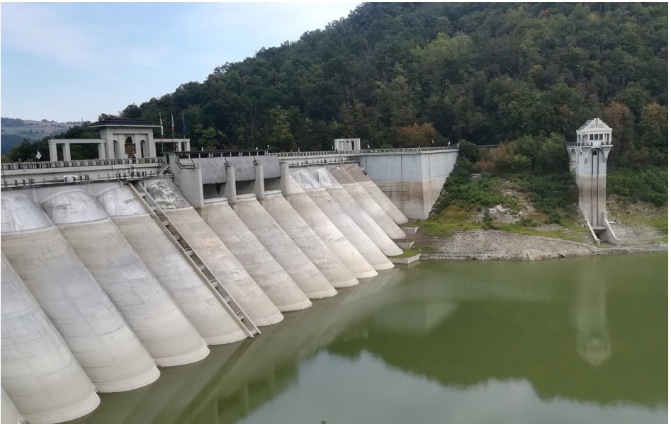
Figura 13 – Presa de Molato, Val Tidone Fuente: Luca Trabattori, Uji University
