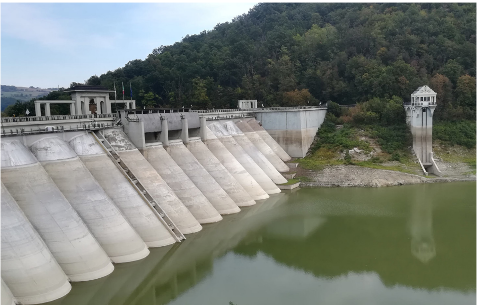
Figure 14 – Diga del Molato, Val Tidone Fonte: Luca Trabattoni, Università di Pavia
